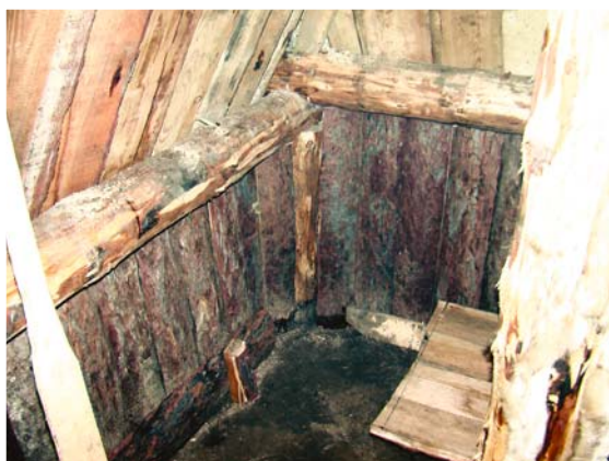
Рис. 4. Оформление угла жилища облицовочными досками.
