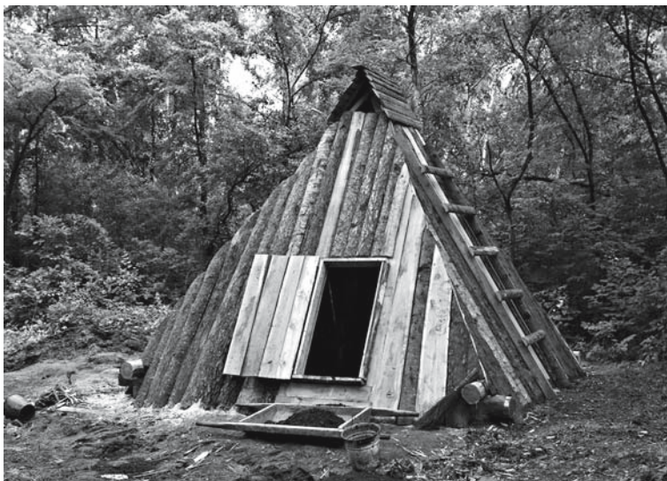
Рис. 6. Внешний вид жилища без гидроизоляции и дернового покрытия.
