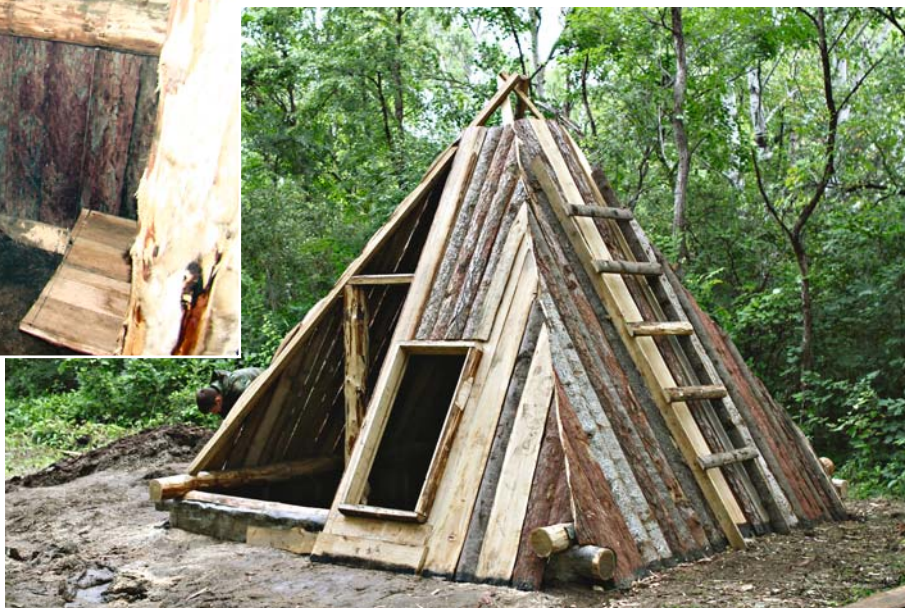
Рис. 5. Перекрытие скатов кровли досками.
