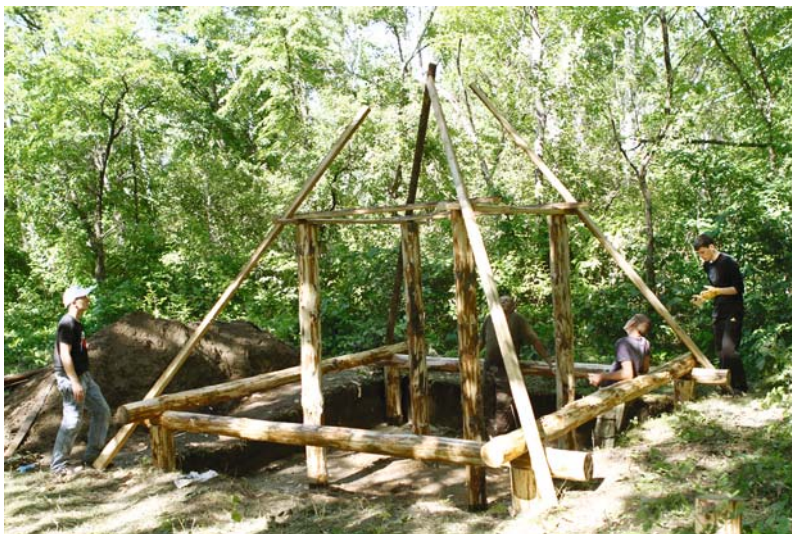
Рис. 2. Сборка каркасно-столбовой конструкции жилища.
