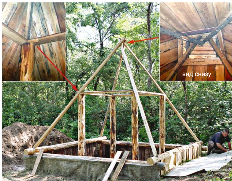
Рис. 3. Каркас жилища с облицовкой стен горбылями и их гидроизоляцией от стен котлована; сочленение верхних концов угловых стропил и углов рамы-обвязки.
