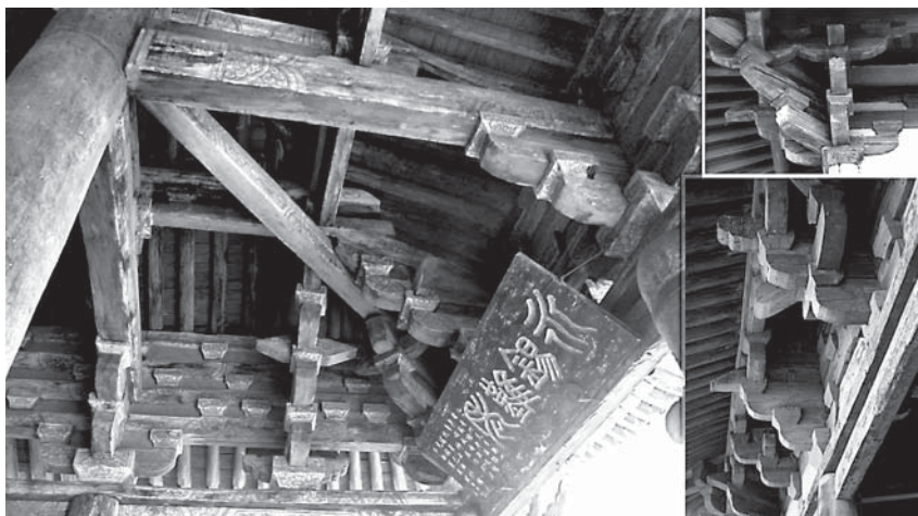
Рис. 3. Различные системы кронштейнов доугун в конструкции храма Шэнмудянь.
