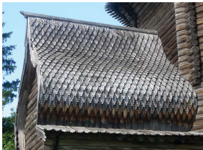
Рис. 6. Покрытие лемехом бочки. Фото А.Ю. Майничевой.
