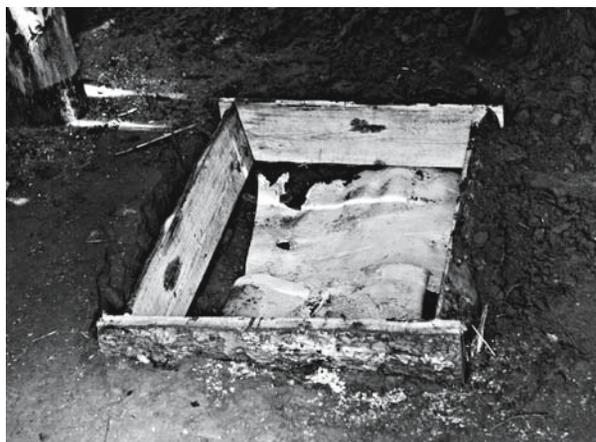
Рис. 11. Дно очага с теплоизолирующим экраном из бересты.
